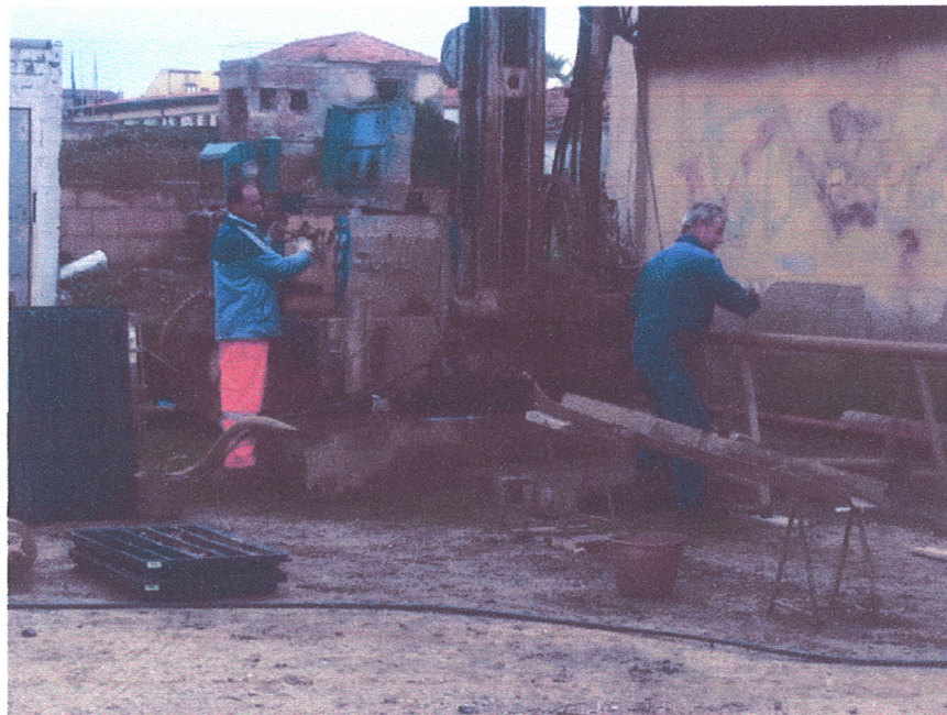
Fig. 3: Esecuzione sondaggio S1
